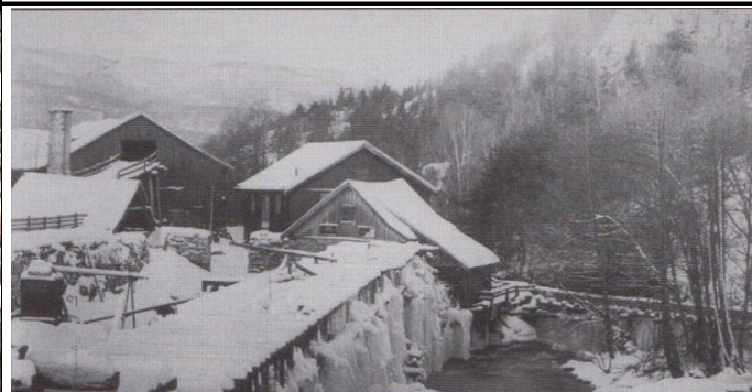
Islagt vannrenne ved øvre dam på Gata
