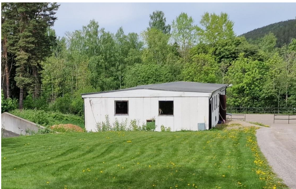
Slik ser bygningen til Holtung skaftefabrikk ut i dag.
